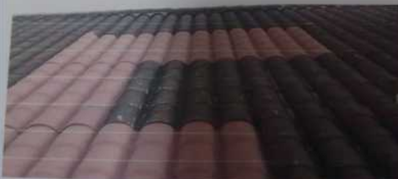
Reposición de Techo de Planta Alta
